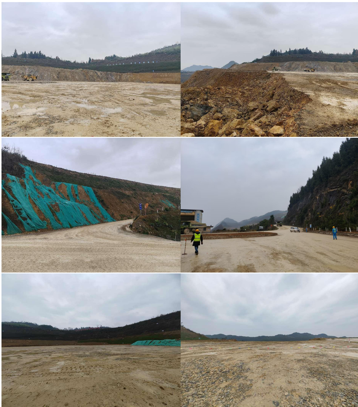
已损毁土地现状照片
